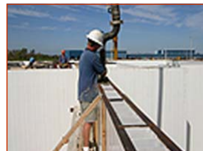
Заливка бетоном
