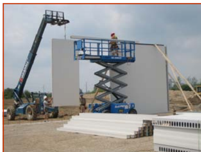
Монтаж стены
